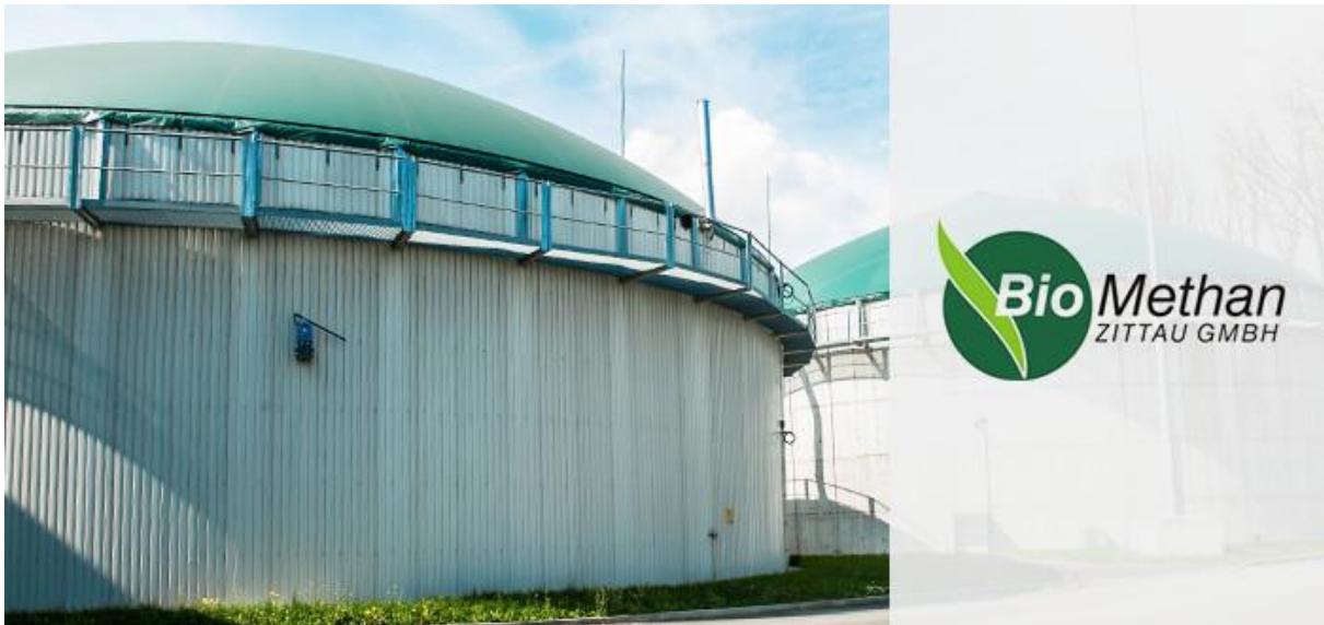
Bild 11 – Biogasanlage (Quelle: Bio Methan Zittau GmbH)
