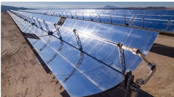
Parabolspiegel in Solarthermiekraftwerk Bildquelle: Adobe Stock
